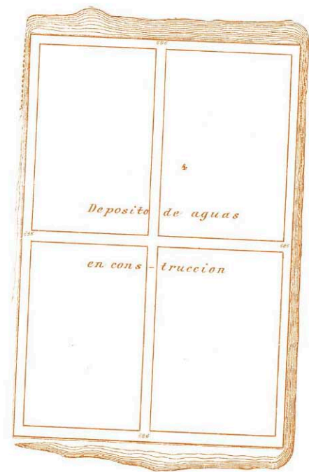
DEPOSITO DE AGUA DEL CANAL DE LOZOYA EN CONSTRUCCION, 1869-1879
